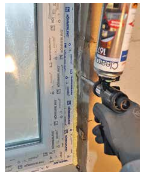
Den feuchtigkeitshärtenden, dauerelastischen 1 K-Klebstoff auf PU-Basis appliziert der Fachmann in die Fuge, die Multifunktionsdüse ist eine Entwicklung von ClearoPAG.
