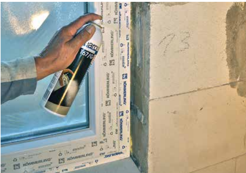
Die wasserbasierte Grundierdispersion 167/G dient wie auf der Illustration zu sehen zur Untergrundvorbereitung und Erhöhung der Umgebungfeuchte.
